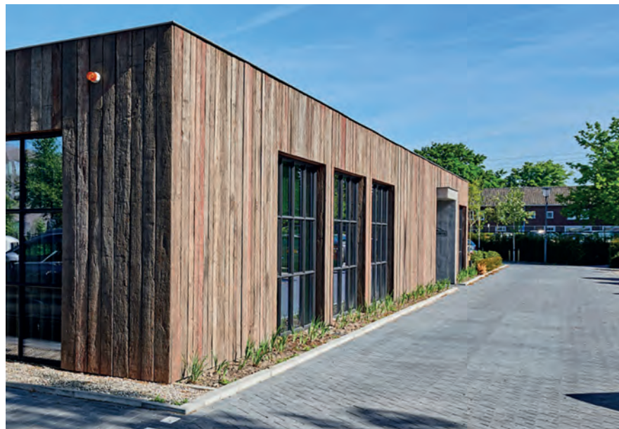
Voor de gevel van dit pand in Oosterwijk leverde Plancker hout aan dat afkomstig is van oude scheepsvloeren.
