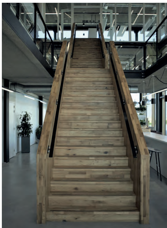
Herso maakte deze trap van hergebruikt hout voor het kantoor van Heembouw in Berkel en Rodenrijs.
