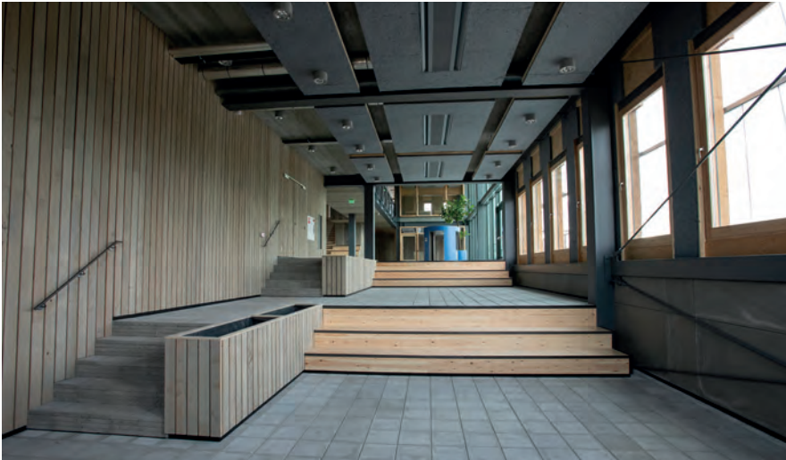
In het kantoor van afvalbeheerder Cure in Eindhoven gebruikte BAM veel hergebruikt hout van CirQ Wood.
