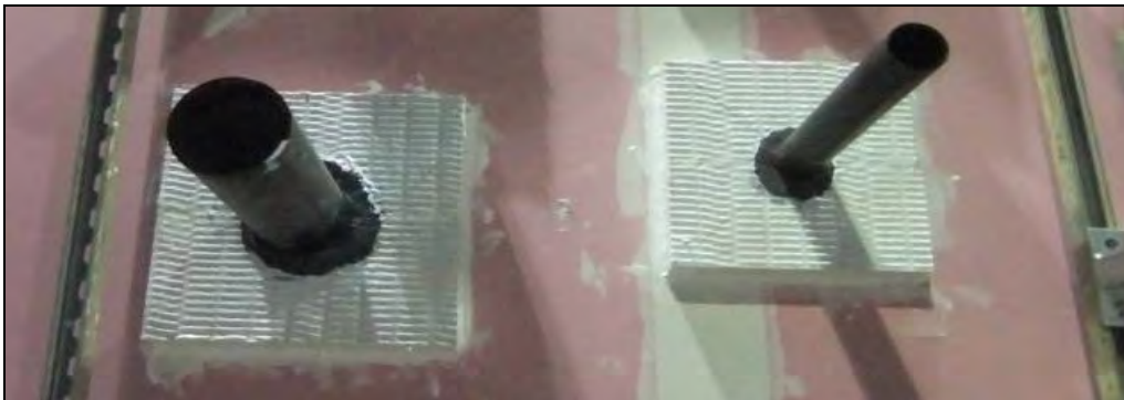
F/Stop Solutions Coated Paneel geïnstalleerd tegen de buitenzijde van de systeemwand rondom de kunststofbuis afgewerkt met F/Stop Solutions Intumescerende grafiet kit (geen coating vereist op doorvoering).
